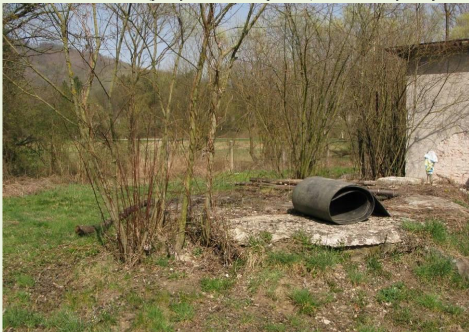
Obr. 26. Nádrž s vodou (prikrytá betónovou platňou) za vodárenským objektom
