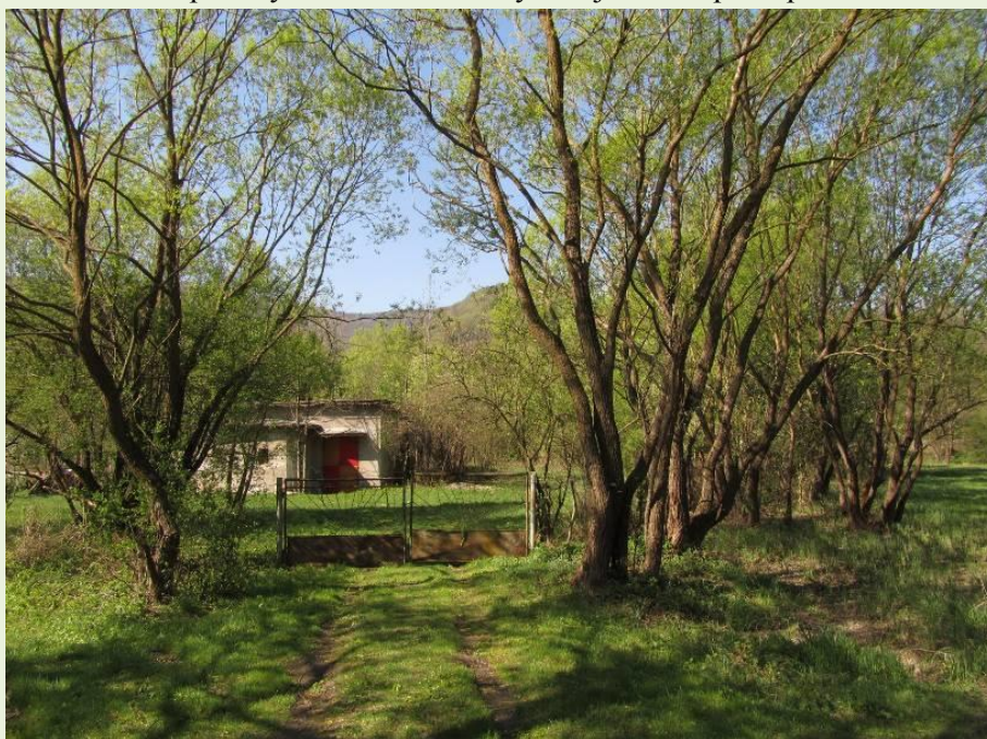
Obr. 24. Oplotený areál s vodárenským objektom s prístupovou cestou
