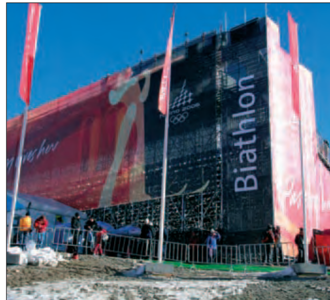
Rozoberateľné tribúny pre divákov na ZOĤ v Turíne boli po skončení hier z dôvodov čo najmenšieho narušenia prostredia demontované
