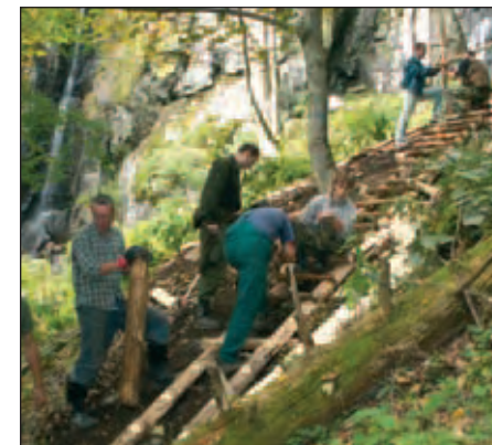
Práce na rekonštrukcii
