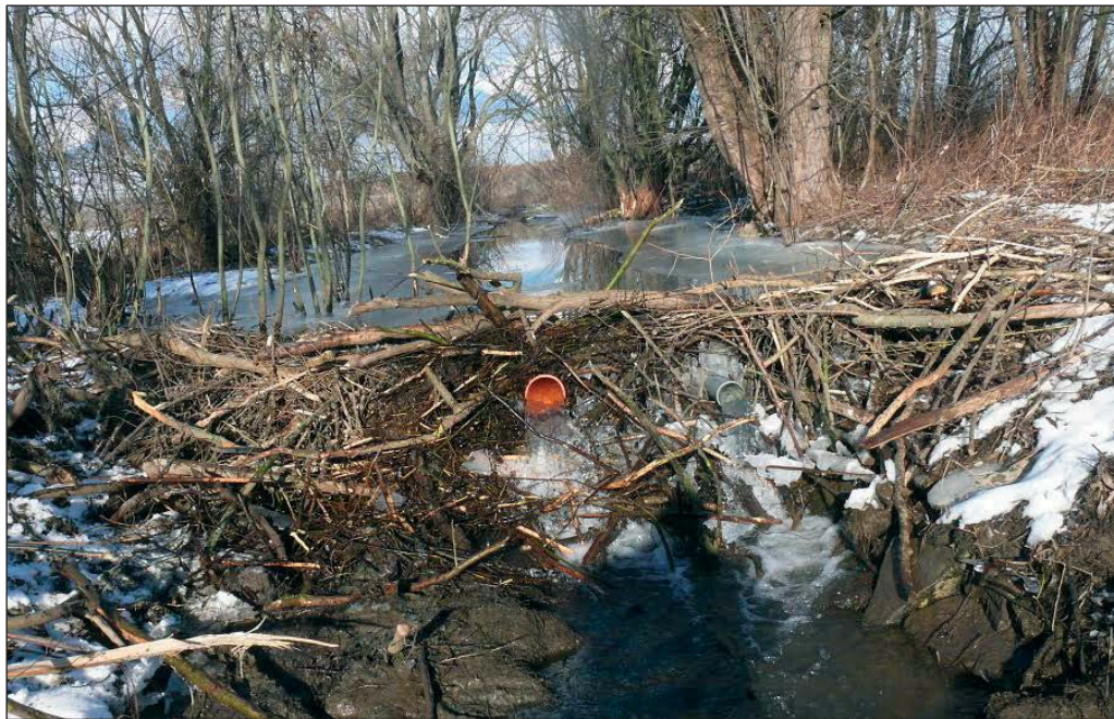
Obr. 1: Drenáž hrádze na potoku Konzajf (Breziny), foto P. Vravník
