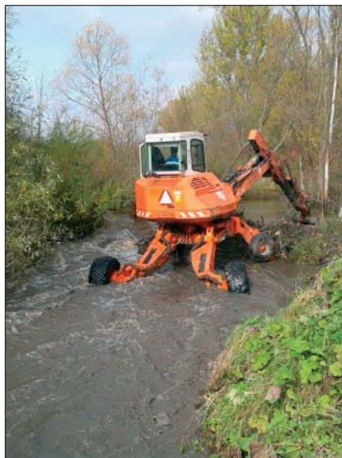
Obr. 4: Odstraňovanie bobrej hrádze na potoku Veľký Lipník, foto: M. Smrek
