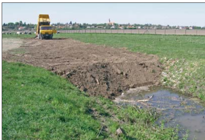
Obr. 6. Zасыpanie drenážneho kanála v celkovej dĺžke 450 m na lokalite Kamenínske slaniská, foto: M. Janák
