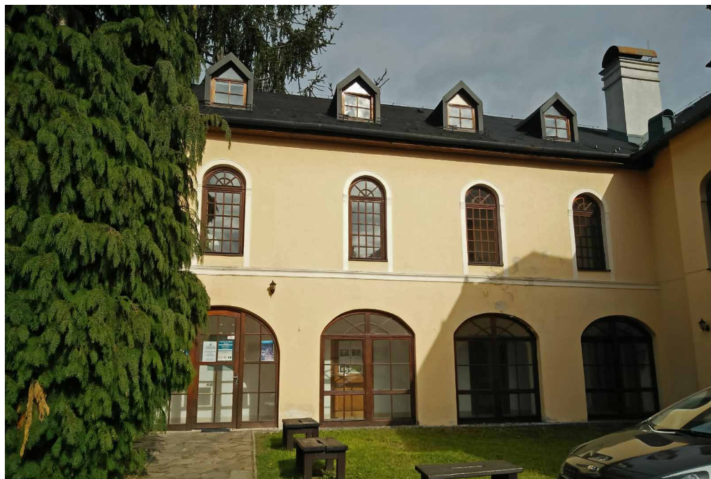
SŠOP v Banskej Bystrici investične zabezpečovalo rekonštrukciu sídla Správy CHKO Štiavnické vrchy na Kammerhofskej ulici č. 26
