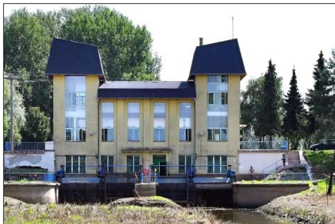
Prečerpávacia stanica Kamenná Moľva – dolu na objekte polia s česlami, vľavo vlečka s naloženými náplavami foto J. Májsky
