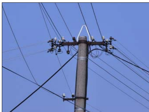
Tento typ zábrany namontovali energetici na stĺpy elektrického vedenia v blízkosti hniezda foto: J. Májsky
