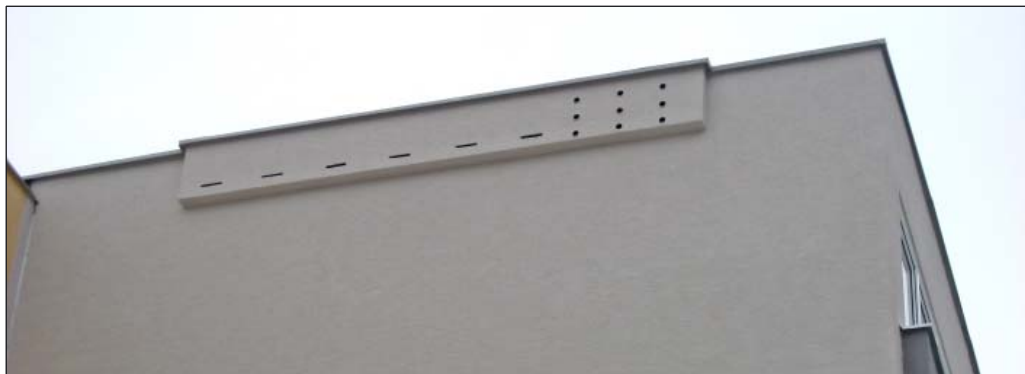
Búdky pre dážďovníky a netopiere nainštalované na zateplenom paneláku v Trnave, foto: J. Filo
