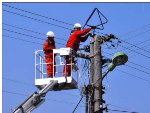
Nový typ zábrany na pôvodnom stĺpe má odradiť bociany od stavby hniezda, foto: J. Májsky
