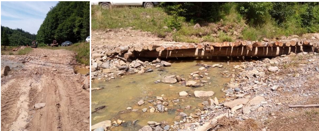
Obr. 11 Dočasné premostenie vodného toku - Rumunsko (Foto: ©M. Hunčaga).
