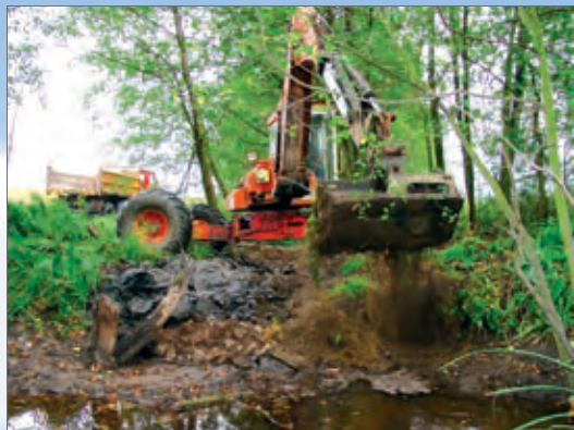
Ochrana mokradí si niekedy vyžaduje aj zasypávanie odvodňovacích kanálov, foto: J. Šíbl
