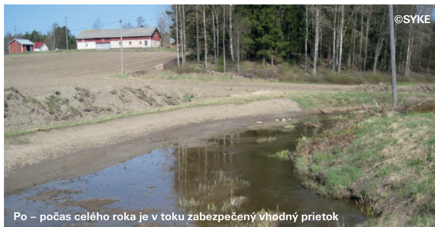
Na ľavom brehu potoka bola vybudovaná záplavová terasa. Právý breh bol ponechaný bez zásahu. Zemina vykopaná pre záplavovú terasu sa použila na prilahlých poliach.
