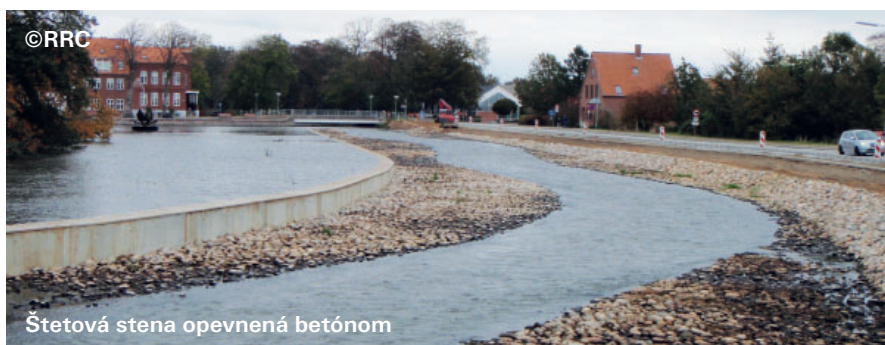
Vybudovanie štetovej steny pre zriadenie hate
