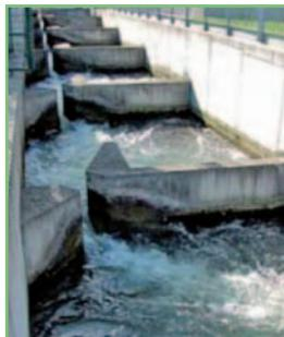
Príklad prúdenia vo veľkokomorovom štrbinovom rybovode (pozri aj obrázok v 3.6.1.). Pod každou nepripustnou prepážkou vznikajú dostatočne rozsiahle zóny s upokojenou vodou pre oddych rýb (Slavík a kol. 2012).
