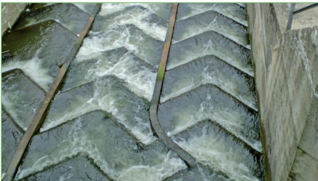
Žlaby zdrsnené rôznymi lamelami brzdia vodu, ale pre kontinuálne plávanie rýb sú úplne nevhodné Foto: autor
