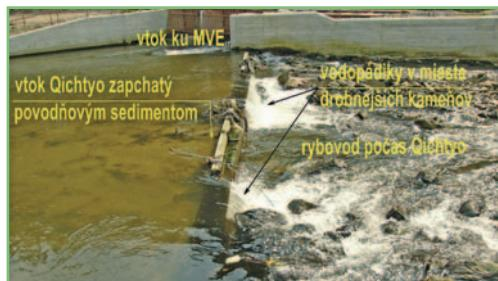
Dôležité plus: Až keď sa naplní vtokový otvor do rieky pre MQ, začne sa voda prelievať ponad zadný prah do MVE. Chyby: 1. Oproti projektu použitý drobnejší kameň voda odnesla a vznikli vodopádky. 2. Natrvalo zhora zahradený vtokový otvor MQ sa počas veľkých vôd zapchá. Podľa projektu sa nad vtokový V otvor malo len počas nízkych prietokov vkladať ocelové horné hradenie. To malo vyčnievať 20 cm nad prah, aby voda neprepadala zhora do rybovodu – dodatočne nahradené hranolmi. Foto: autor
