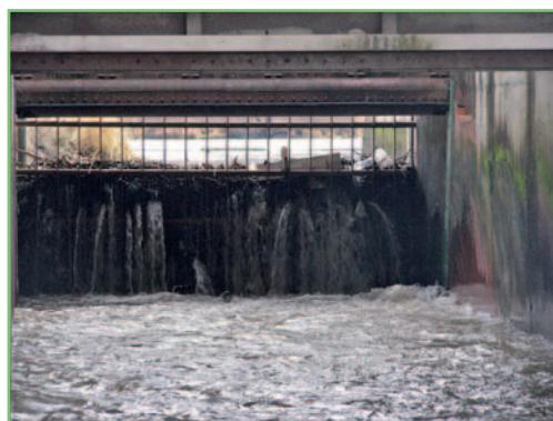
Vodné dielo (VD) Žilina – sklápacieľný rampový kovový rybovod. Foto: autor
