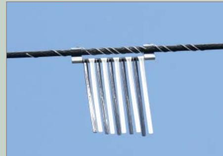
Výstražná značka na elektrickom vedení / Warning device on power lines
