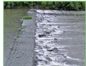
Pri brehu nasypaná kamenno-štrková bystrinná rampa je kvôli vodopádiku len selektívne priechodná. Foto: autor
