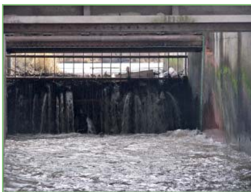
Vodné dielo (VD) Žilina – sklápaťelný rampový kovový rybovod. Foto: autor
