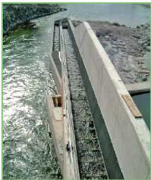
Mimoriadne účinné spomaľovanie bystrinného toku štetinami umožňuje prekonanie veľkých prevýšení na malom priestore (vľavo nedostavaná Ružbašská Míľava na Poprade, vpravo Liebenau). Foto: P. Dušička, P. Glaus
