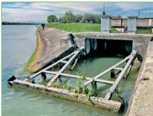
Dva príklady hradenia dostatočne predsadeného pred vtokový otvor (Slavík a kol. 2012)
