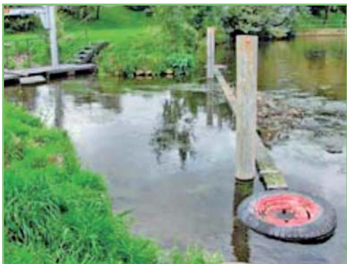
Dva príklady hradenia dostatočne predsadeného pred vtokový otvor (Slavík a kol. 2012)
