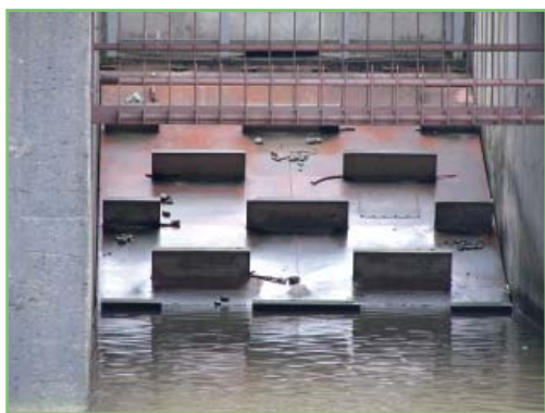
Vodné dielo (VD) Žilina – sklápaťelný rampový kovový rybovod. Foto: autor
