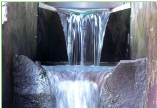
Podmienkou priechodnosti pre pstruhy je prevýšenie hladín, neprekračujúce 0,5 m (tu 0,45 m), a koncentrovaný hrubý vodný lúč (tu 15 cm), vznikajúci vďaka výraznému preliačeniu v strede prepážky. Foto: autor
