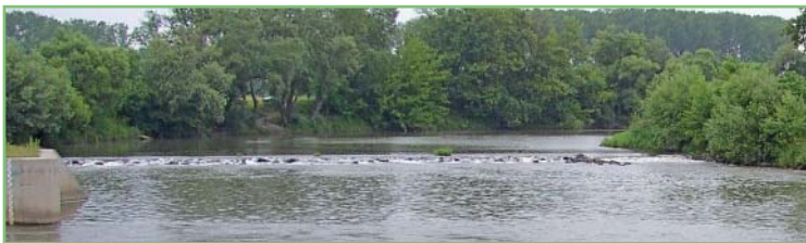
Problém: celokorytové bazény, ktoré zavodňujú ochudobnené koryto rieky pri derivačnej MVE, sú tvorené selektívne priechodnými kamenno-betónovými prepážkami. Foto: autor
