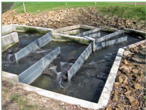
Mimoriadne účinné spomaľovanie bystrinného toku štetinami umožňuje prekonanie veľkých prevýšení na malom priestore (vľavo nedostavaná Ružbašská Míľava na Poprade, vpravo Liebenau). Foto: P. Dušička, P. Glaus
