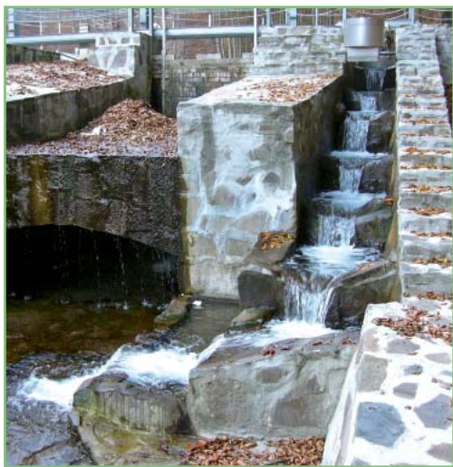
Vodopádový pstruhový rybovod dokáže prekonať veľký výškový rozdiel 4 m na trase len 13 m. Hĺbka vody v každej komore je až 75 – 80 cm nad prepážkou. Šírka komory je 80 cm, dĺžka 130 cm, takže väčšina vodného bazénu je bez turbulencií a spenenia. Dolná komora (vstup pre ryby) je na úrovni dna potoka, ktoré malo ostať prirodzené. Foto: autor
