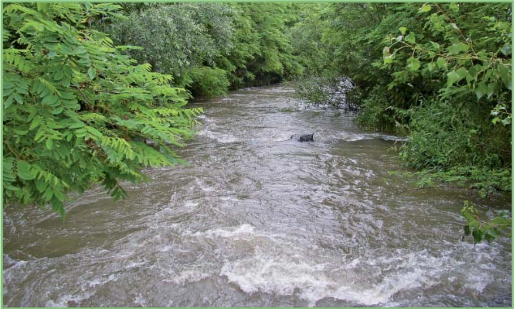
Vhodné migračné prostredie vo veľkorozmernom koryte bazénového obtokového rybovodu s výrazne rozostúpenými prepážkami, pohltené náletovými brehovými porastmi. Foto: autor
