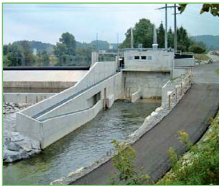
Mimoriadne účinné spomaľovanie bystrinného toku štetinami umožňuje prekonanie veľkých prevýšení na malom priestore (vľavo nedostavaná Ružbašská Míľava na Poprade, vpravo Liebenau). Foto: P. Dušička, P. Glaus
