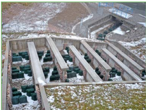
Mimoriadne účinné spomaľovanie bystrinného toku štetinami umožňuje prekonanie veľkých prevýšení na malom priestore (vľavo nedostavaná Ružbašská Míľava na Poprade, vpravo Liebenau). Foto: P. Dušička, P. Glaus
