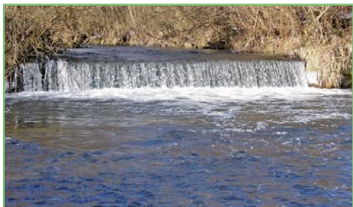
Nepriechodná migračná bariéra Muránka I pred spriechodnením – vodopádový riečny stupeň s prevýšením hladín 1 m. Foto: autor
