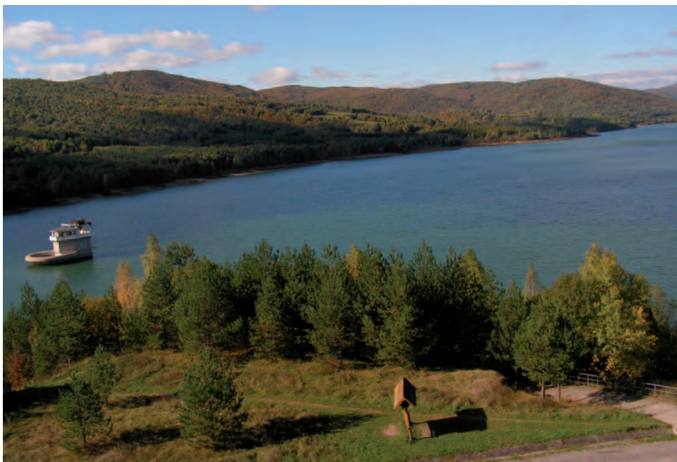
Vodárenská nádrž Starina
