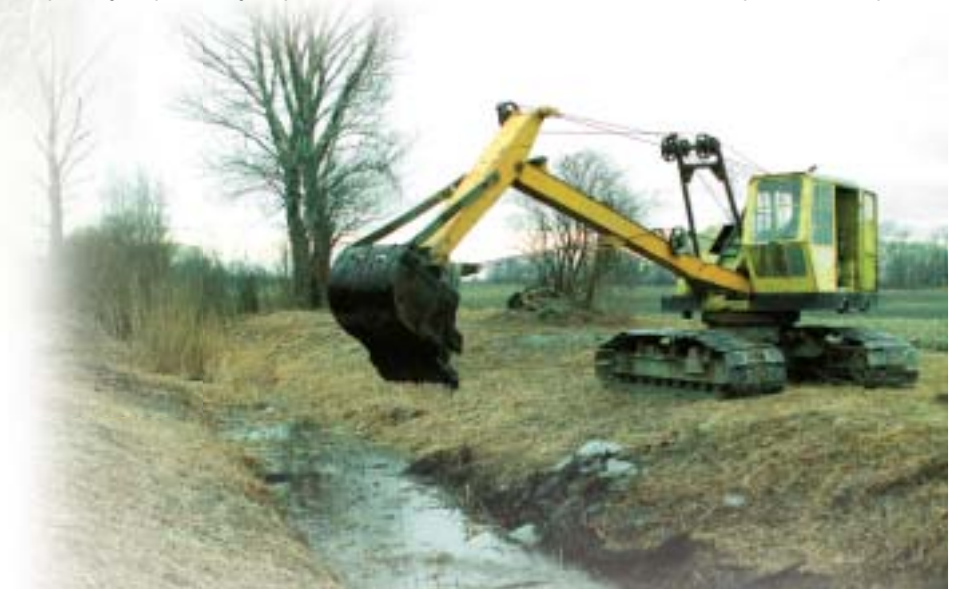
Revitalizačné opatrenia - prerušované hĺbenie bažinovým bagrom E 304 Foto: J. Hajdú
