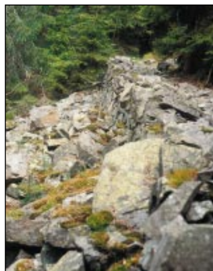
Oporný múr pre trasu vodovodu
