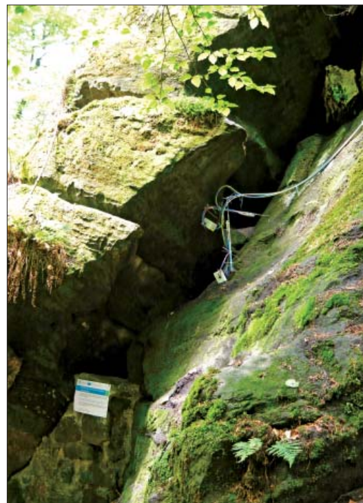
Monitoring bezpečnosti pieskovcových skál
