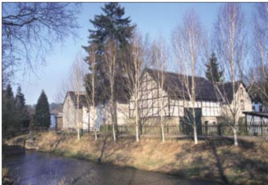
Budova správy a informačné stredisko Národného parku Eifel
