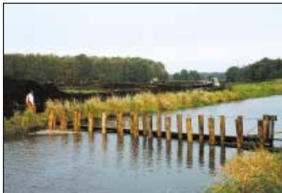
Stavba prehrádzok v alúviu rieky Recknitz
