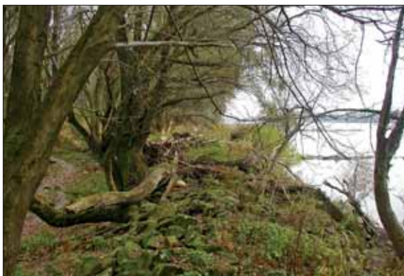
Výtok do ramena je od hlavného toku oddelený kamenným opevnením brehov
