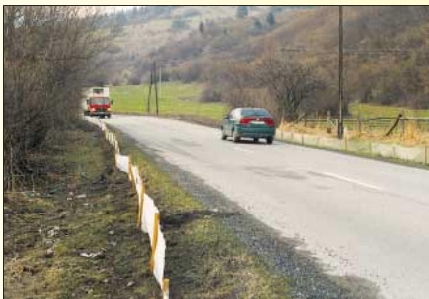
Dočasné ochranné zariadenie, inštalované po obidvoch stranách vozovky za účelom zachytenia jedincov prichádzajúcich na reprodukčnú vodnú plochu, ale aj jedincov odchádzajúcich na svoje letné teritórium v smere cez vozovku
