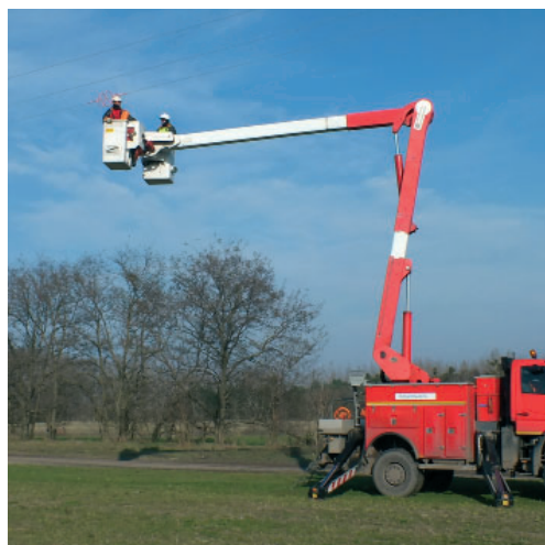
Inštalácia odkloňovacích prvkov na elektrické vedenie 22 kV za pomoci odizolovanej plošiny foto: Ochrana dravcov na Slovensku
