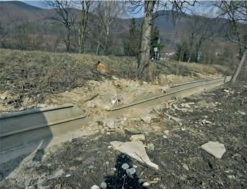
Obr. 12: Nevýhodou zvoleného riešenia je len krehkosť materiálu. Pri kolaudačnej obhliadke sme našli úsek rozbitý po dopravnej kolízii s líškou. Poškodené diely je nutné vymeniť. Foto: M. Apfelová
