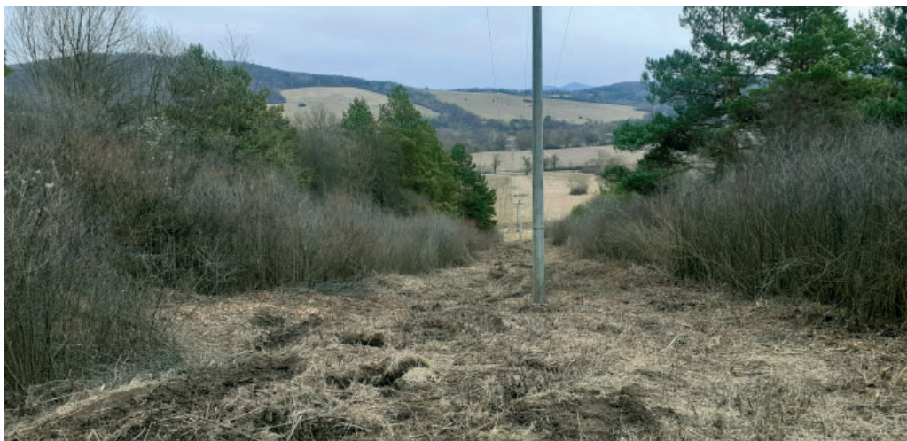
Krovinový okraj v ochrannom pásme VN vedenia, vyčistenie koridoru prebehlo len v pásve v šírke cca 8 – 10 m, foto: Ľ. Vadel
