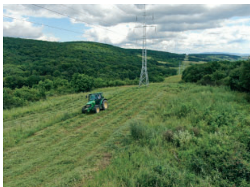
Kosenie stredového pásu v koridore elektrického vedenia, foto: Ľ. Vadel
