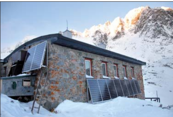
Téryho chata po komplexnej rekonštrukcii foto: M. Tomeček – Tomis, s. r. o.
