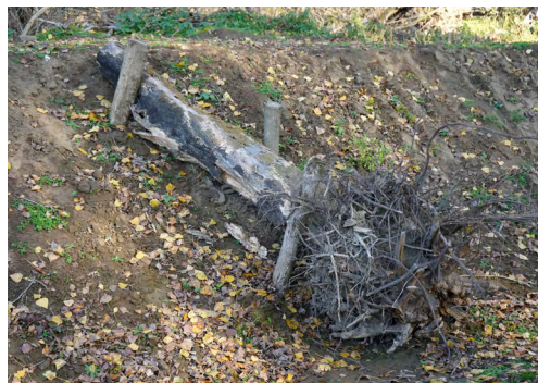
Obr. č. 6. Fixované mŕtve drevo (stavebný objekt SO 01 – prepoj ramena). Mŕtve drevo okrem vplyvu na hydraulické podmienky významne ovplyvňuje aj biotickú zložku riečného ekosystému, napríklad zvyšuje primárnu produkciu. Foto: autor článku
