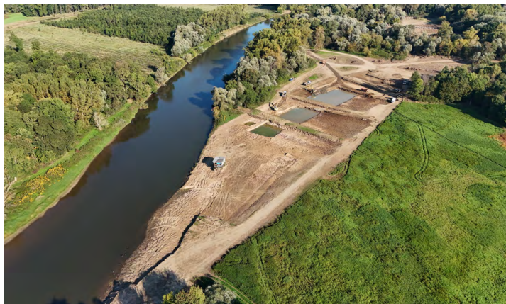
Obr. č. 1. Práce na revitalizácii rieky Morava. Úsek obnovovaného meandra, ktorému sa vráti po 65. rokoch funkcia hlavného toku. Existujúce koryto bude v celom priereze zavezené materiálom získaným výkopovými prácami v rámci stavby. Stavebný objekt SO 04, 63,2 rkm, september 2025. Foto: SVP, š. p. 2
