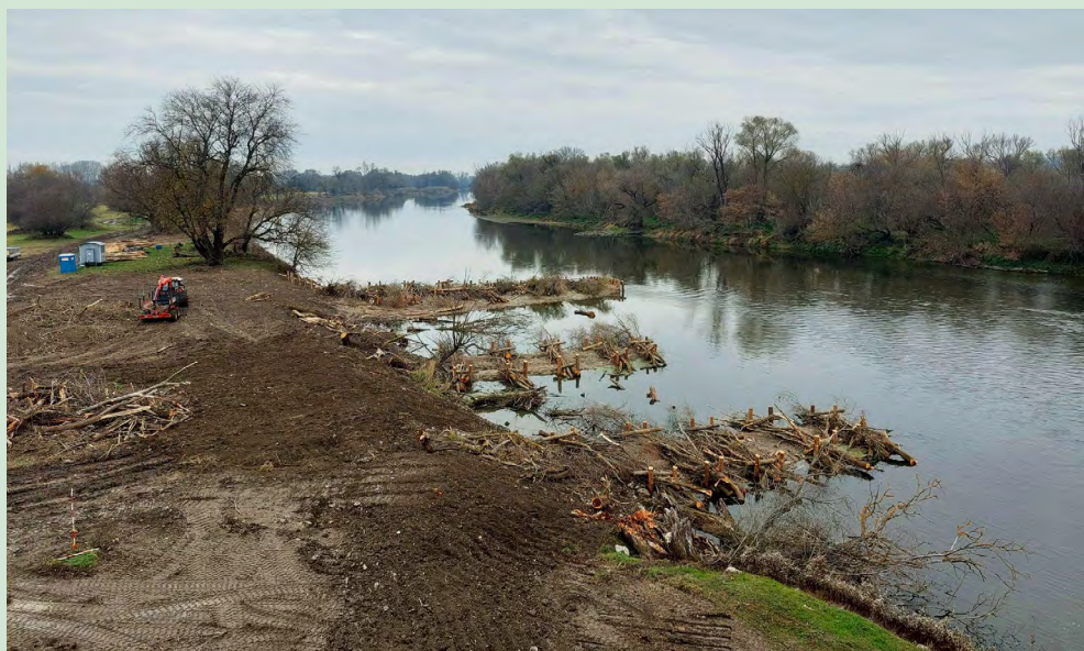
Obr. č. 7. Budovanie výhonov na 5. rkm rieka Morava na rakúskej strane.
