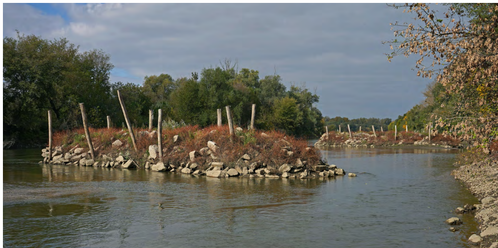
Obr. č. 4. Kamenné výhony – smerové stavby v rieke Morava rkm 2,00. Projekt Kli-Ma Optimalizácia vodných stavov na Morave pri zvláštnom zohľadnení klimatických zmien. Foto: autor článku
