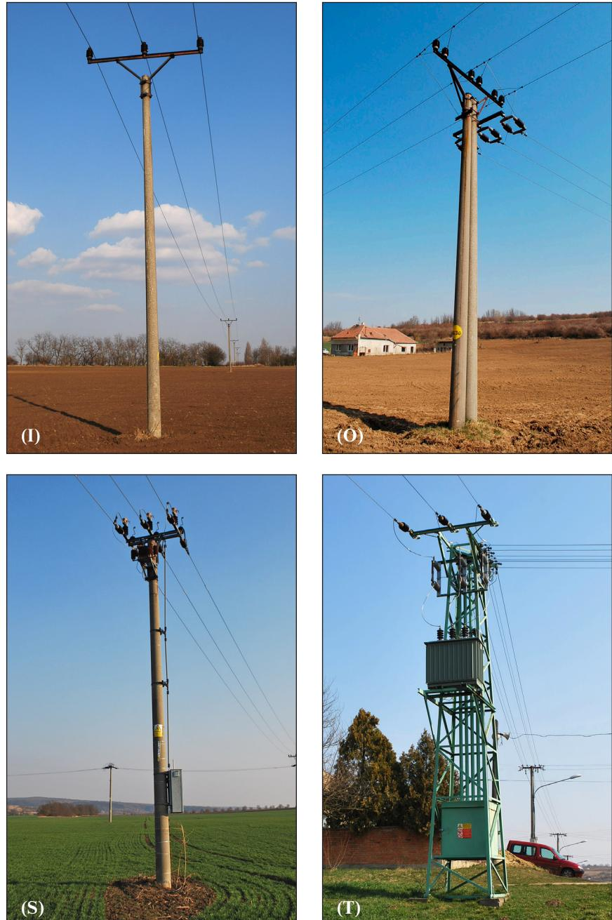
**Obr. 3:** Základné rozdelenie stĺpov 22 kV prítomnom území: (I) stĺp na priamej línií, (O) odbočný stĺp s viacerými konzolami a rôznym umiestnením izolátorov a preponiek, (R) rohový stĺp s rôznym umiestnením preponiek, (S) úsekový odpínač, (T) transformátor, foto: M. Gális
