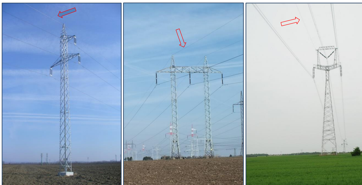
Obr. 22 Vizuálne porovnanie viditeľnosti ZL a vodičov na vedeniach typu 110 kV, 220 kV a 400 kV
