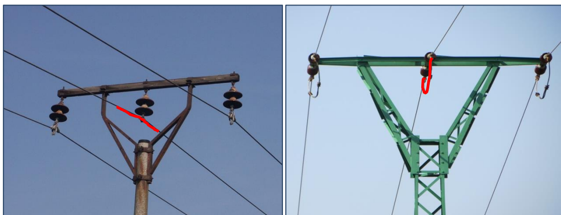
Obr. 43 Visiaca preponka na strednej fáze môže byť rizikom pre väčšie druhy vtákov
