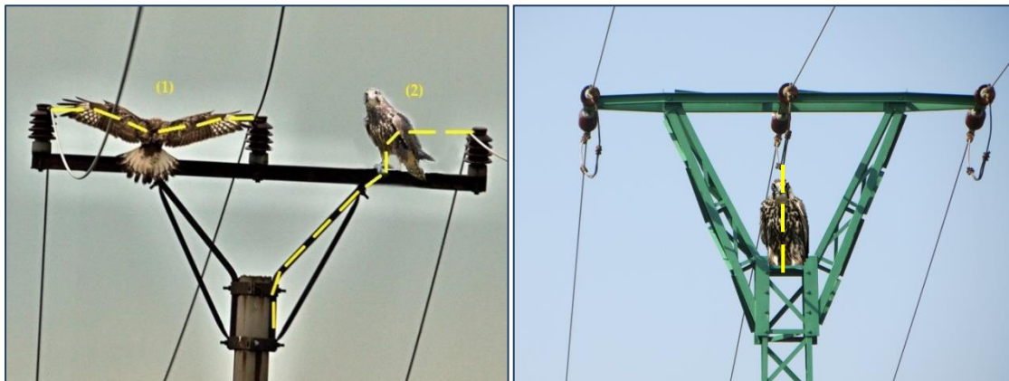
Obr. 10 Najčastejšie spôsoby preskoku prúdu na konzole 22 kV
