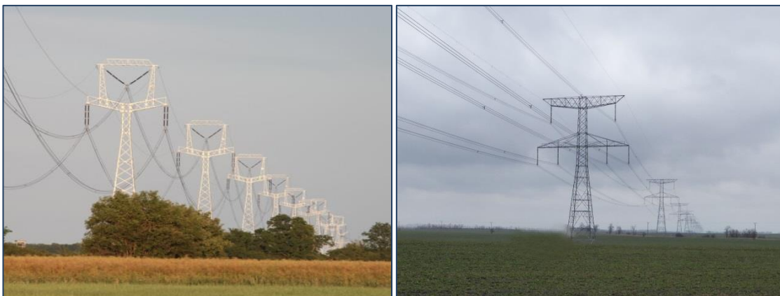
Obr. 3 Najčastejšie typy stožiarov liniek 400 kV v krajine
