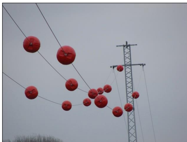
Obr. 52 Nadmerné použitie prvkov zvyšuje náklady energetických spoločností a ohrozuje aj samotné energetické zariadenie
