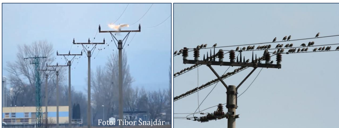
Obr. 26 Skrat vedenia v dôsledku nárazu labute veľkej a zaťaženie vodičov krdľom vtákov
