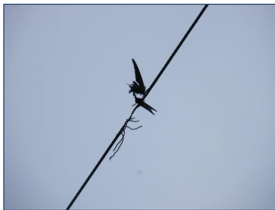
Obr. 29 Poškodenia fázového vodiča v dôsledku nárazu letiaceho vtáka
