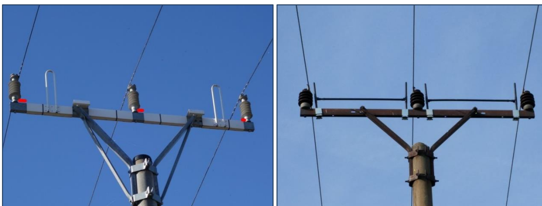
Obr. 37 Rizikové miesta, ktoré zostali po výmene izolátorov a nový typ teleskopického prvku, ktorý pokrýva celý rozsah medzi podpornými izolátormi
